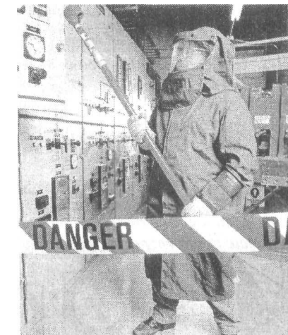
Rys. 7.13. Wyposażenie elektryka w sprzęt ochronny przy eksploatacji urządzeń elektroenergetycznych znajdujących się pod napięciem. [107]
